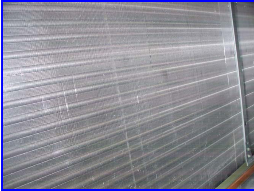
RTU -GYMNASIUM FARTHEST FROM FLAGPOLE –BLOWER FINS
